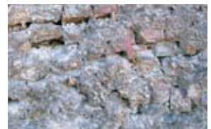
▲8号窯の補修された壁
