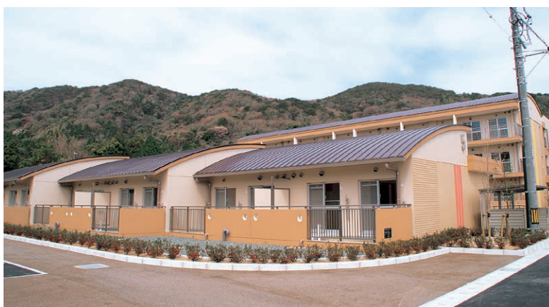
完成した緑ヶ丘住宅 ▶
