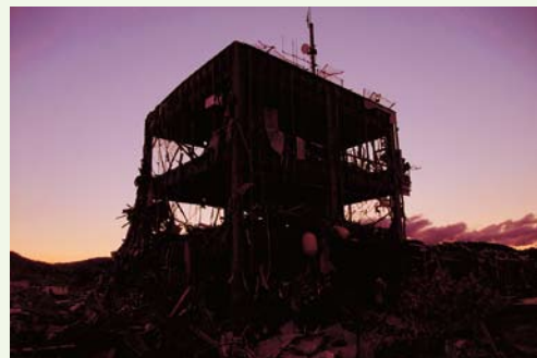
▲3階屋上まで津波が到達した南三陸町防災対策庁舎
