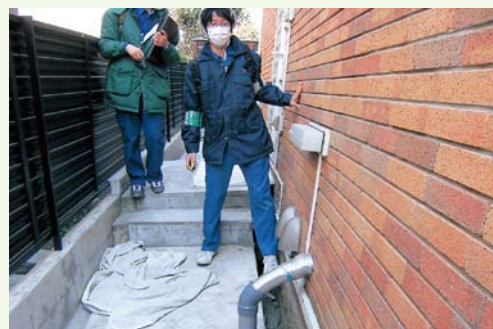
▲液状化で傾いた家屋の被害調査（浦安市）
