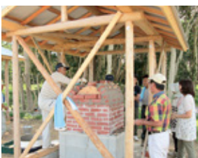
▲丁寧に石窯をつくる様子
