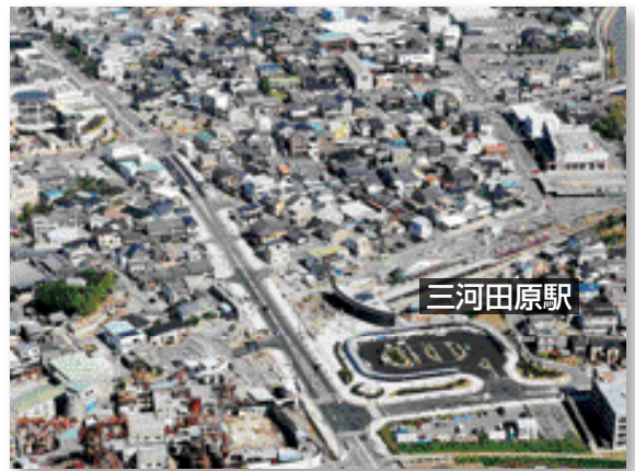
▲竣工間近の駅前通り線と新三河田原駅の航空写真(H25.10.21)
