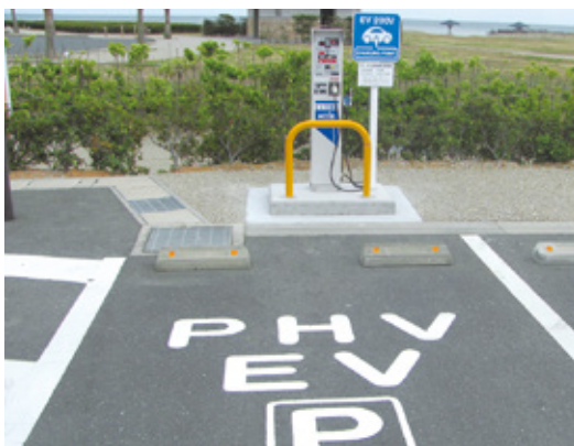
▲道の駅あかばねロコステーションに整備した充電器
