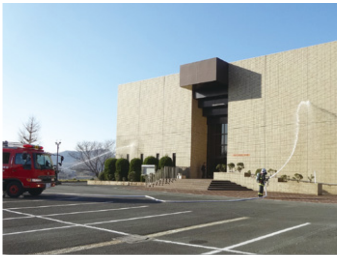
▲放水訓練を行う消防署員(渥美郷土資料館)
