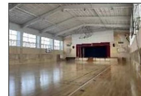
屋内運動場長寿命化改修後
