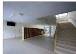
校舎長寿命化改修後
