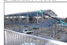
童浦小学校屋内運動場工事中
