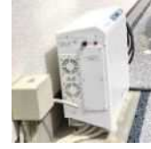
V2H(電気自動車充電設備)
