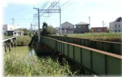
渥美線田原川橋梁補強工事 ※神戸駅～三河田原駅間
