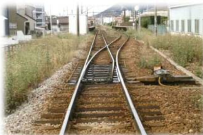
渥美線レール更新工事 ※豊島駅～神戸駅間
