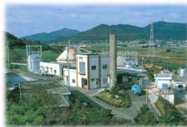
田原市衛生センター(昭和41年供用開始)
