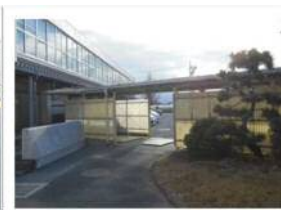
▲⑨:体育館連絡通路
