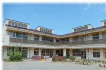
解体撤去する山北保育園
