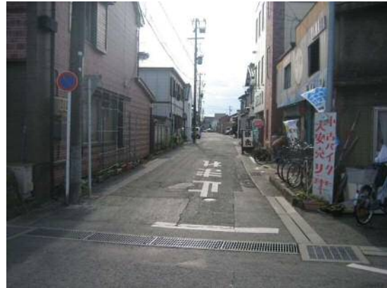
ウォーキングトレイル修景工事 施行箇所写真
