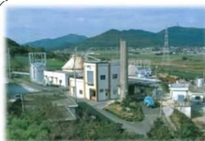
田原市衛生センター(昭和41年供用開始)
