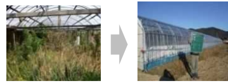
老朽施設の改修による再生
