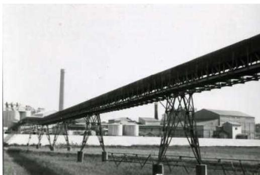
昭和40年当時のベルトコンベア(石灰石・粘土搬入)
