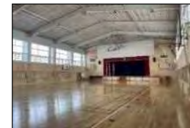
屋内運動場長寿命化改修後
