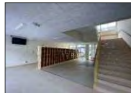
校舎長寿命化改修後
