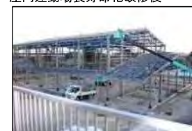
童浦小学校屋内運動場工事中
