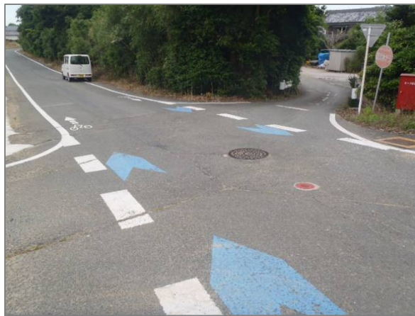
車道上の自転車通行空間の例（六連地区）
