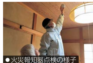
●火災報知器点検の様子
