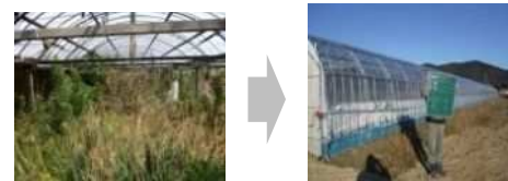
老朽施設の改修による再生
