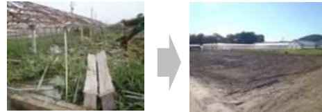
老朽施設の撤去による再生
