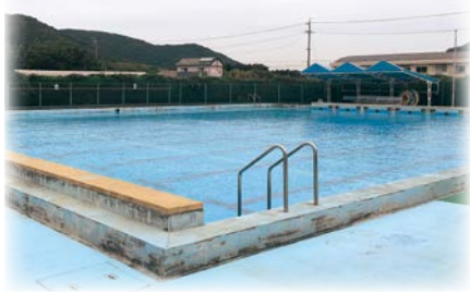
▲老朽化が進むプール
