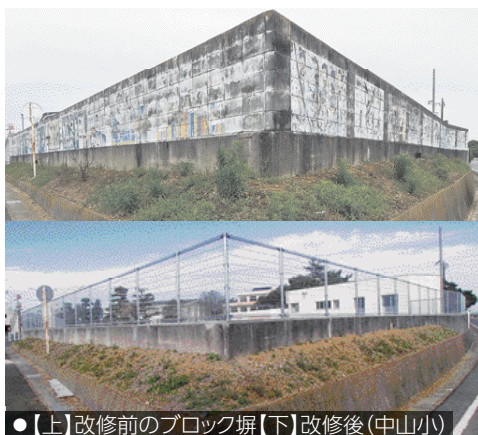
●【上】改修前のブロック塀【下】改修後(中山小)
