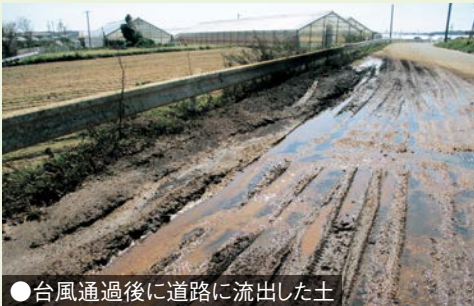
●台風通過後に道路に流出した土
