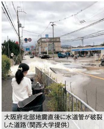
大阪府北部地震直後に水道管が破裂した道路(関西大学提供)
