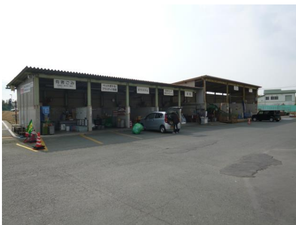
資源ごみストックヤード(東部資源化センター)
