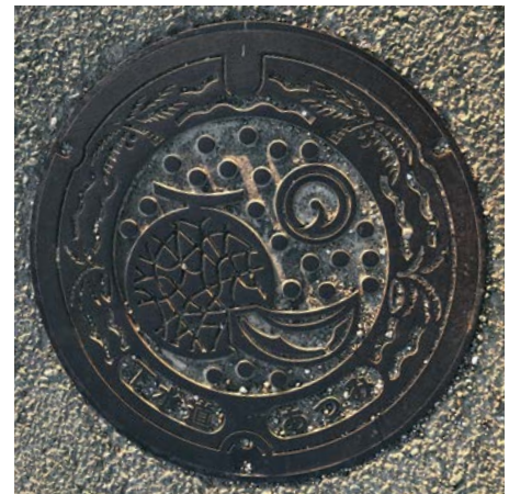
▲渥美地区のマンホール
