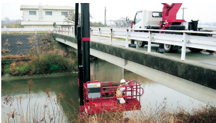
▲ 橋の点検の様子 (長寿命化対策)
