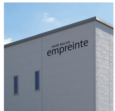
▲白色の外壁に、黒色の広告物(文字)の組み合わせが、洗練された印象を与えています。(田原市)
