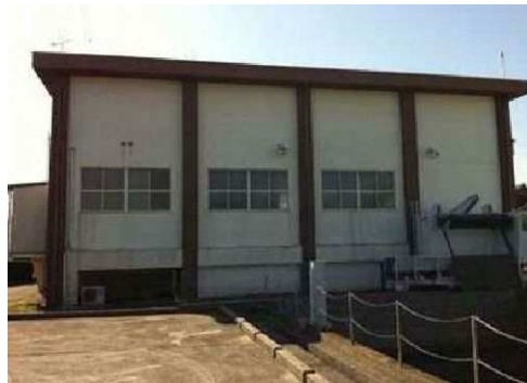
東大浜ポンプ場
