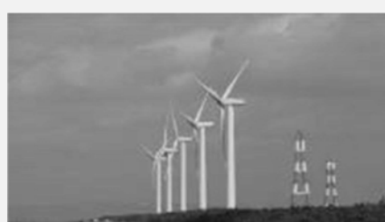
渥美風力発電所（小中山地内）
