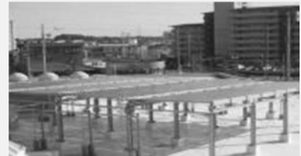
田原福祉センター太陽熱利用施設
