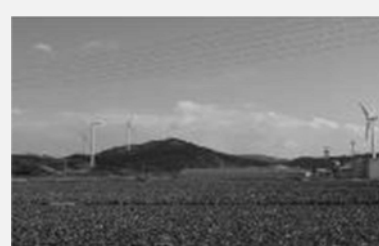
渥美風力発電所（小塩津地内）
