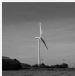
久美原風力発電所
