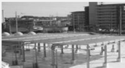
田原福祉センター太陽熱利用施設
