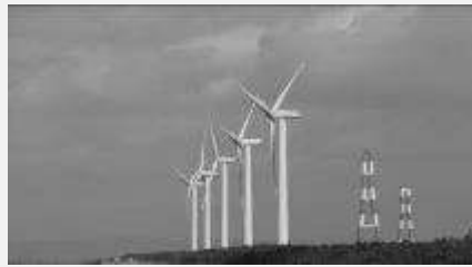
渥美風力発電所 (小中山地内)
