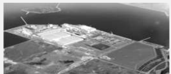
メガソーラーたはら発電所 建設予定地 (田原4区)
