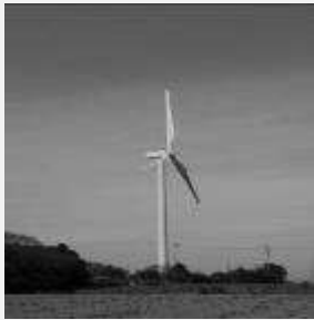
久美原風力発電所
