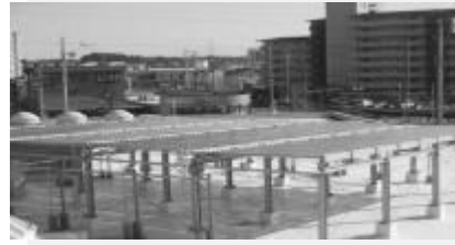
田原福祉センター太陽熱利用施設
