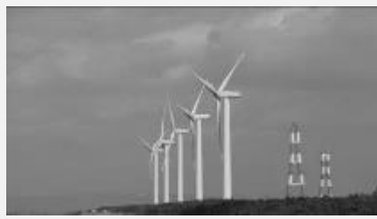
渥美風力発電所 (小中山地内)
