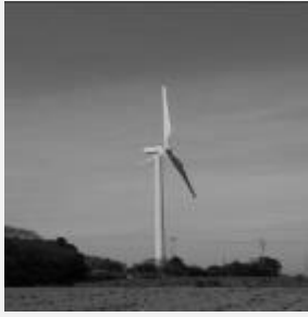
久美原風力発電所
