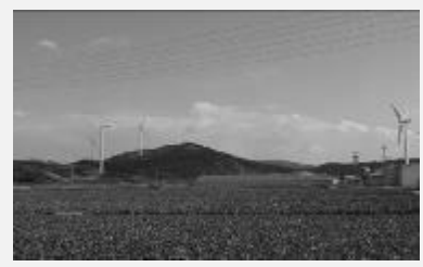
渥美風力発電所 (小塩津地内)
