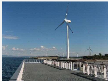
田原臨海風力発電所
