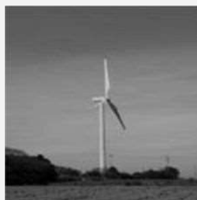
久美原風力発電所
