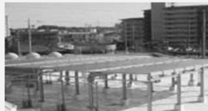
田原福祉センター太陽熱利用施設
