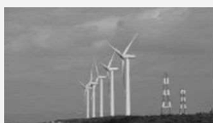
渥美風力発電所（小中山地内）
