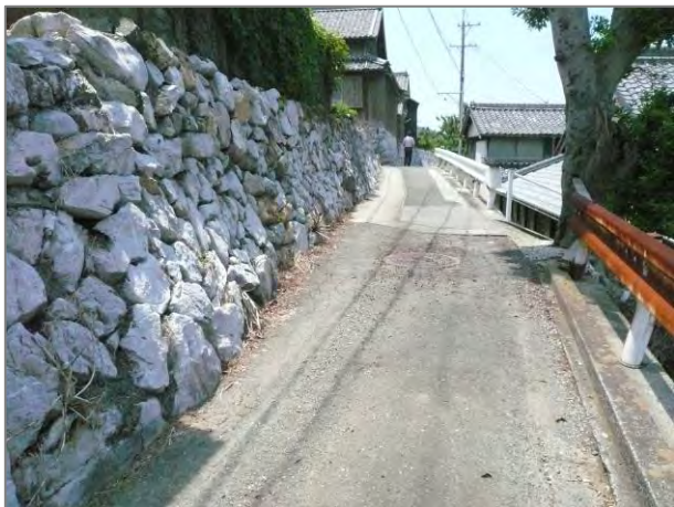
石灰岩の石積み
