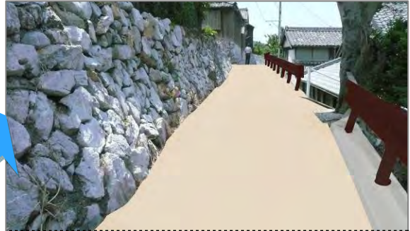
・ 景観的に配慮した舗装やガードレール
