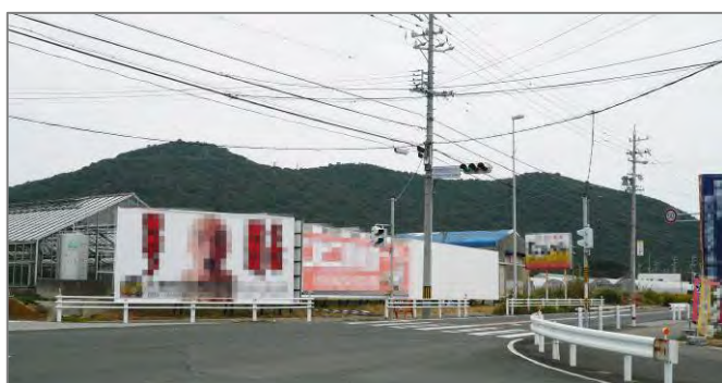
電線類の錯綜
