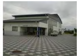
白谷海浜公園 センターハウス
