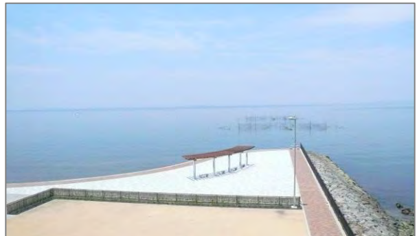
修景デザインに配慮した港の施設
