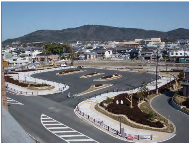
整備中の駅前広場
