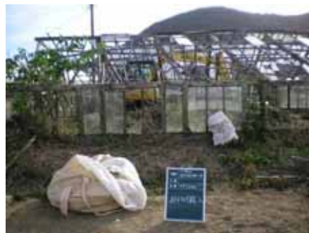
再生作業中（老朽化施設撤去）
