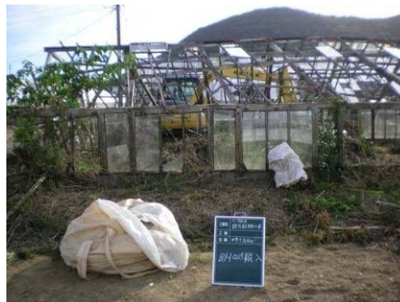
再生作業中（老朽化施設撤去）
