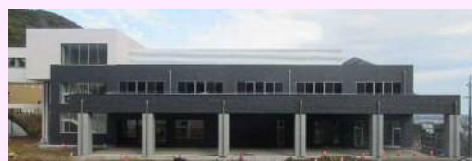
完成した新斎場(火葬棟) ※外構部はR3年度に整備予定
