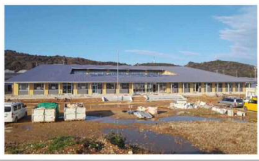
●伊良湖岬小学校校舎棟現況写真
