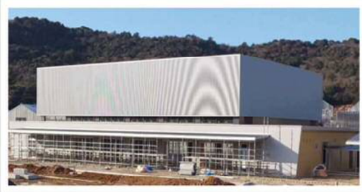
●伊良湖岬小学校体育館棟現況写真
