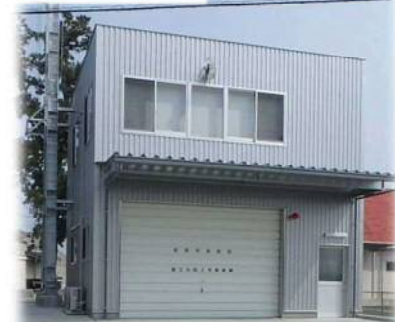
【消防団詰所車庫】
