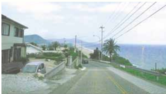
美しい海岸景観の眺望を電柱や電線類、白いガードレールが分断しています。
