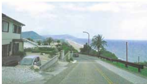
電柱や電線類を整理し、ガードレールを落ち着いた色合いに変えると、海や半島の景観がハッキリします。
