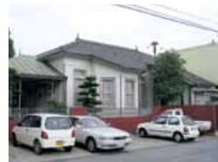
内柴邸離れ(茶室・座敷・洋館)
