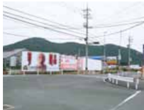
電線類の錯綜
