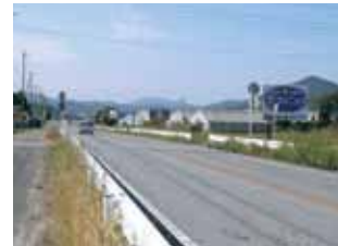
道路の雑草(国道259号)
