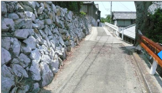
・ 景観的配慮のない舗装やガードレール
