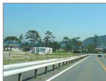
通常の白いガードレール
