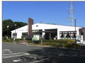
緑が浜公園 センターハウス
