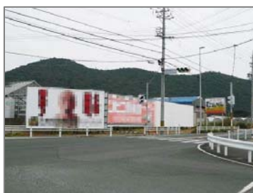
電線類の錯綜
