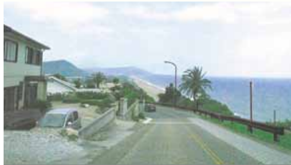
電柱や電線類を整理し、ガードレールを落ち着いた色合いに変えると、海や半島の景観がハッキリします。
