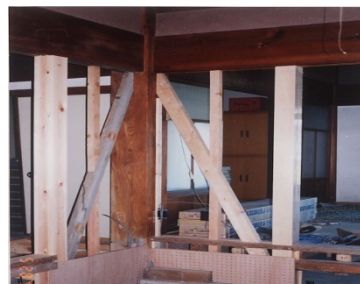
木造住宅耐震改修
