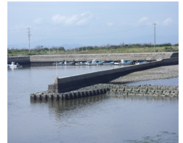
防波堤、護岸、係留施設等の機能保全工事実施
