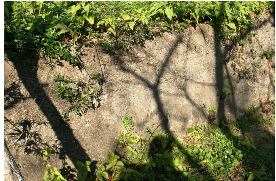
昭和27年(1952)に裏山に設置された暖地園芸試験場のコンクリート擁壁(高さ1m、厚さ10cm)には、崖崩れや地滑りによるひび割れやはらみ出しなどの変形は見られない。
