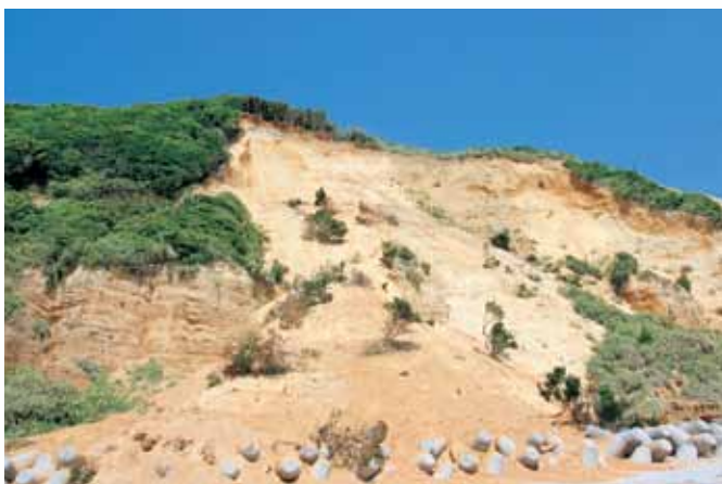
▲大雨などによって崩落した崖森 (H21.8 東ヶ谷海岸)
