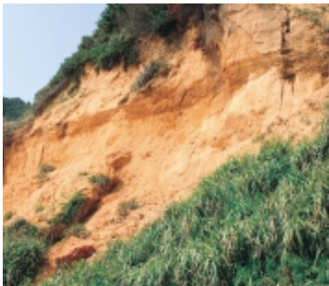
大雨等により崩落した崖(ほうべ)／大草海岸
