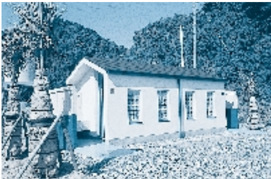
計画により建設された海岸便所(大草海岸)
