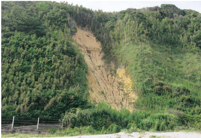
大雨などによって崩落した崖森(南町海岸)
