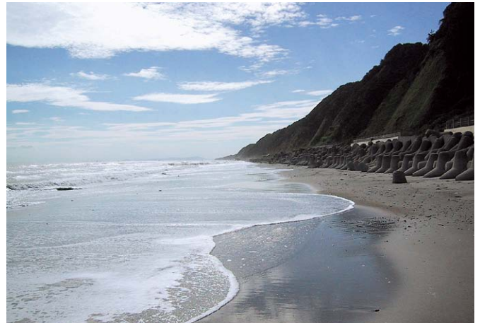
侵食が進む現在の砂浜(東ヶ谷海岸)
