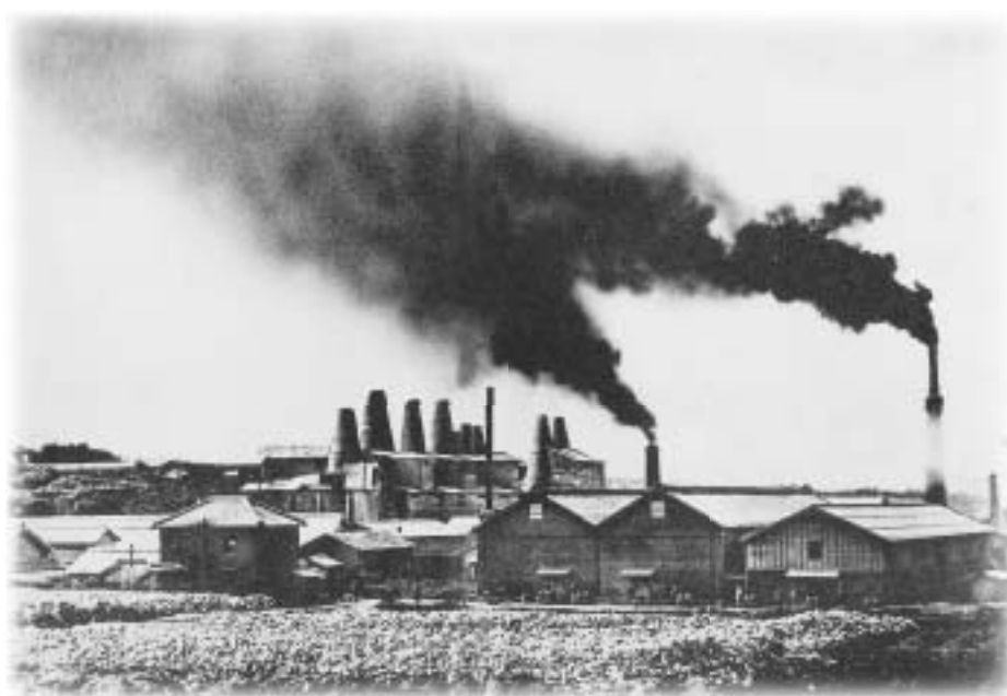
笹川、長谷川が見たセメント工場（明治40年）。中央奥に並んでいるのが徳利窯
